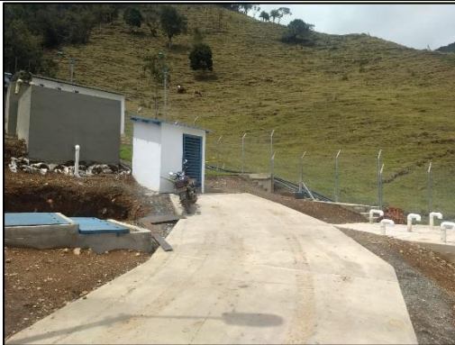
Avance de obra
