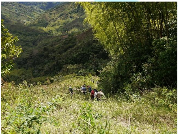
Recorrido por infraestructuras con alcaldía municipal – Tubería al tanque del Chuzo
