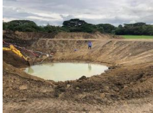
Manejo de taludes succión EBAR
