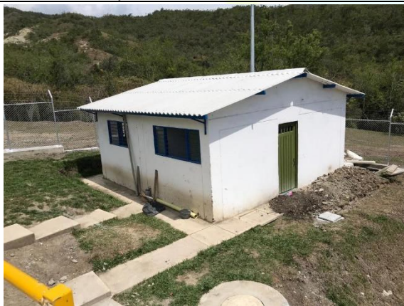
Avance en caseta de operación
