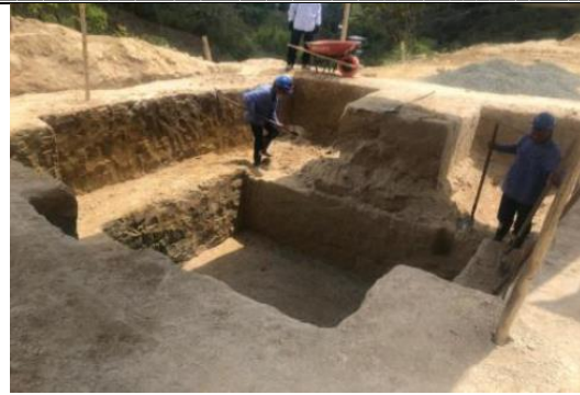
Excavación manual filtro grueso ascendente
