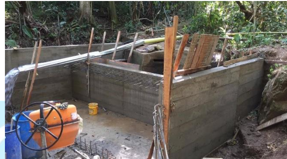
Avance en estructura de captación y desarenador
