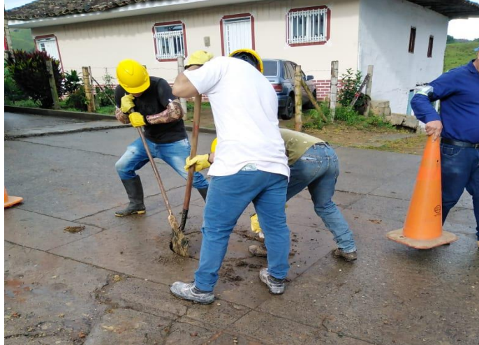
Recorrido por los tramos a intervenir
