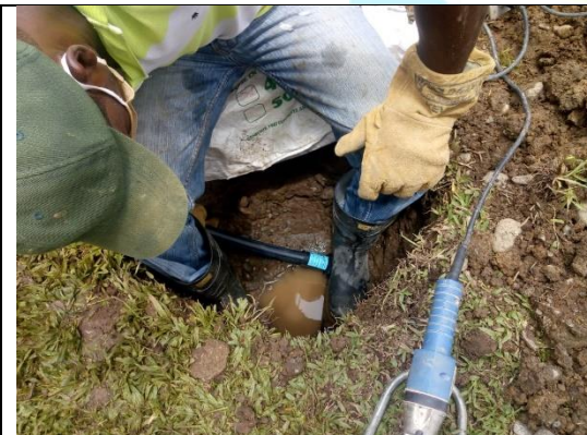
Instalación de acometidas Córdoba
