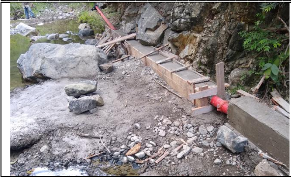
Avance en línea de aducción
