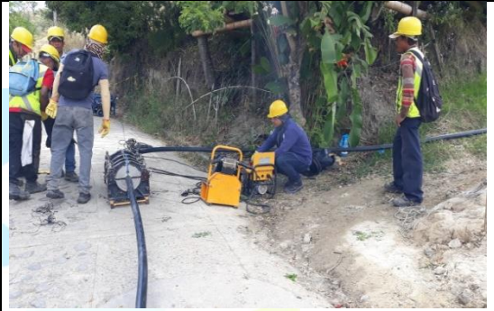
Instalación de tubería
