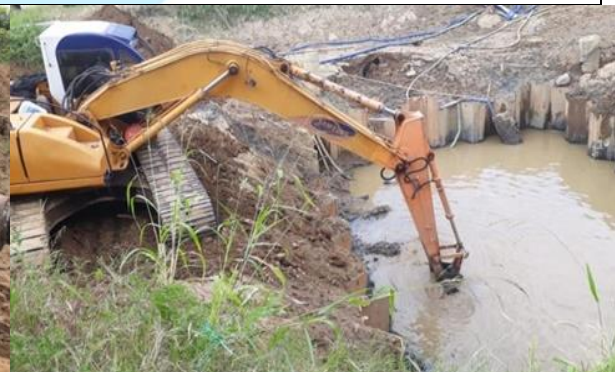
EXCAVACION PARA CIMENTAR AREA DONDE SE CONSTRUYE LA EBAR.
