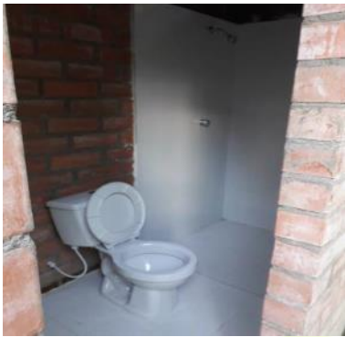
Inst. aparato sanitario y enchape Bateria sanitaria nueva
