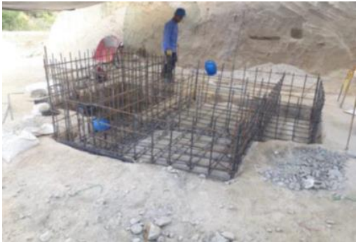
Acero de refuerzo filtro dinámico
