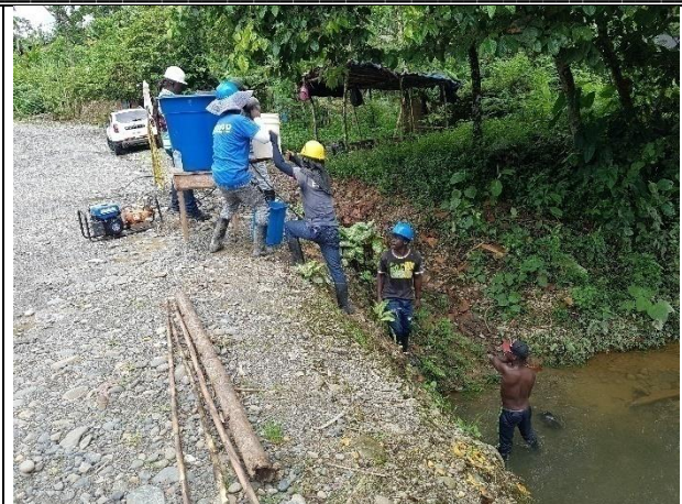
Lleno de tubería para prueba hidráulica
