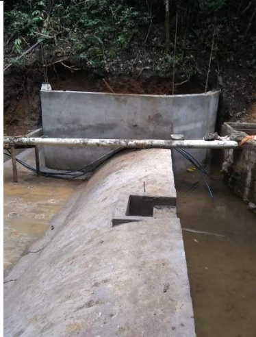
Avance en estructura de captación y desarenador
