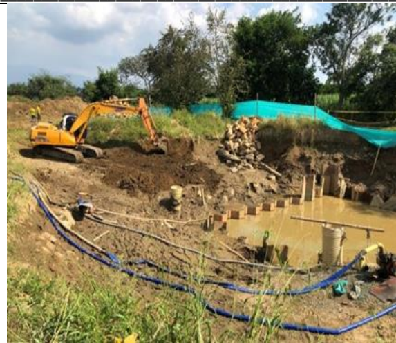
ALISTAMIENTO Y CONFORMAIN DEL CARRETEABLE , ADYACENTES A LA EBAR
