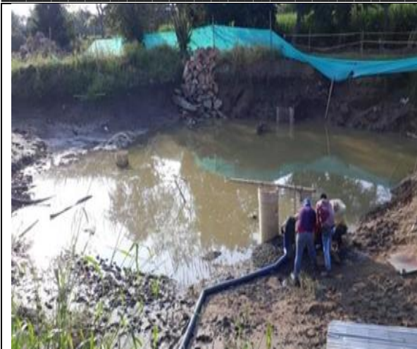
CERRAMIENTO UTILIZANDO TELA VERDE Y LIMPIEZA DE LOS POZO DE SUCCION.
