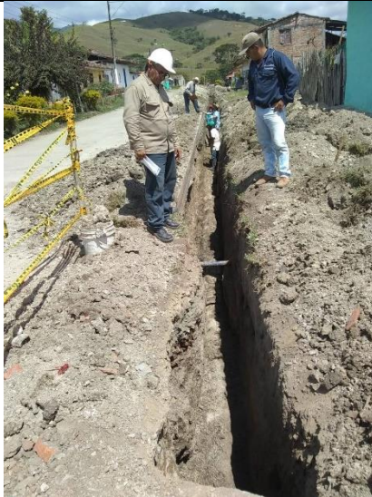
Avance en red de distribución
