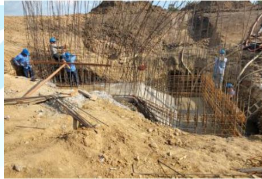
Acero de refuerzo muros pozo de succión EBAR
