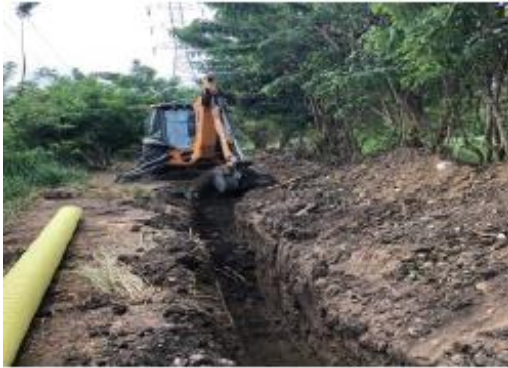
Excavación a máquina tramo IMCA.
