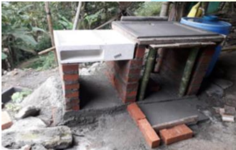
Construcción lavadero vivienda MesiasValencia
