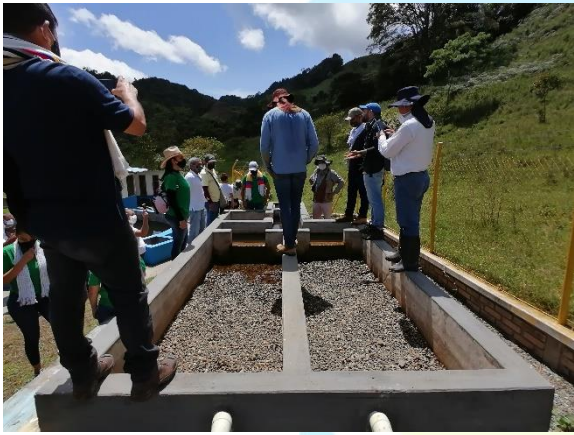
Recorrido por infraestructuras con alcaldía municipal – Filtro Grueso
