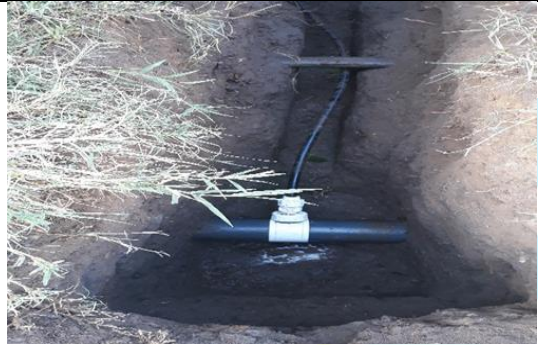
Instalación de acometidas
