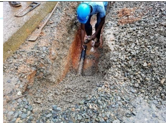
Instalación de tubería y relleno
