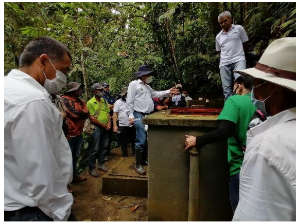
Recorrido por infraestructuras con alcaldía municipal - Desarenador
