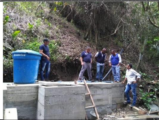
Construcción Desarenador
